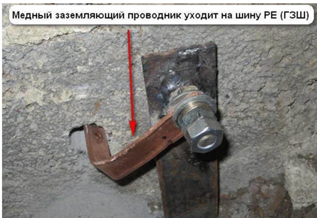
Рис. 1.2.7 Связь контура повторного заземления с ВРУ в виде медной шины
