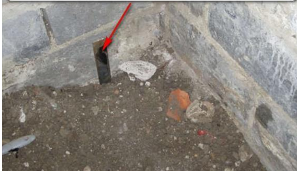
Рис. 1.2.6 Вывод заземляющей полосы от контура заземления
